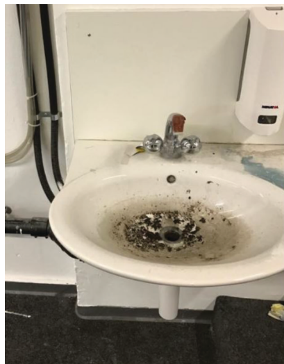
Abb. 2.1 Entstopfen / Ersetzen Vorher
