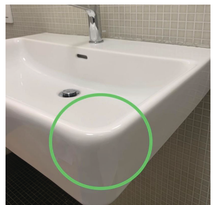
Abb. 3.2 Entstopfen / Ersetzen Nachher
