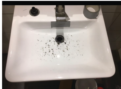
Abb. 1.1 Entstopfen / Ersetzen Vorher
