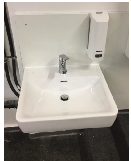
Abb. 2.2 Entstopfen / Ersetzen Nachher
