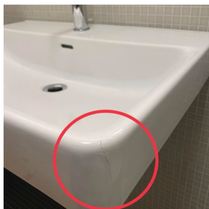
Abb. 3.1 Entstopfen / Ersetzen Vorher
