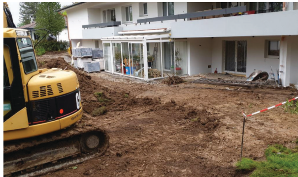
— Abb. 1 Schwimmbad 8600 Dübendorf
