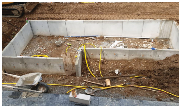
— Abb. 2 Schwimmbad 8600 Dübendorf
