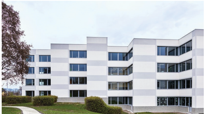
— Abb. 1 Schulhaus Ennetgraben, 8909 Affoltern a.A.
