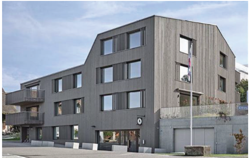
— Abb. 1 Sägi Areal, 8045 Zürich
